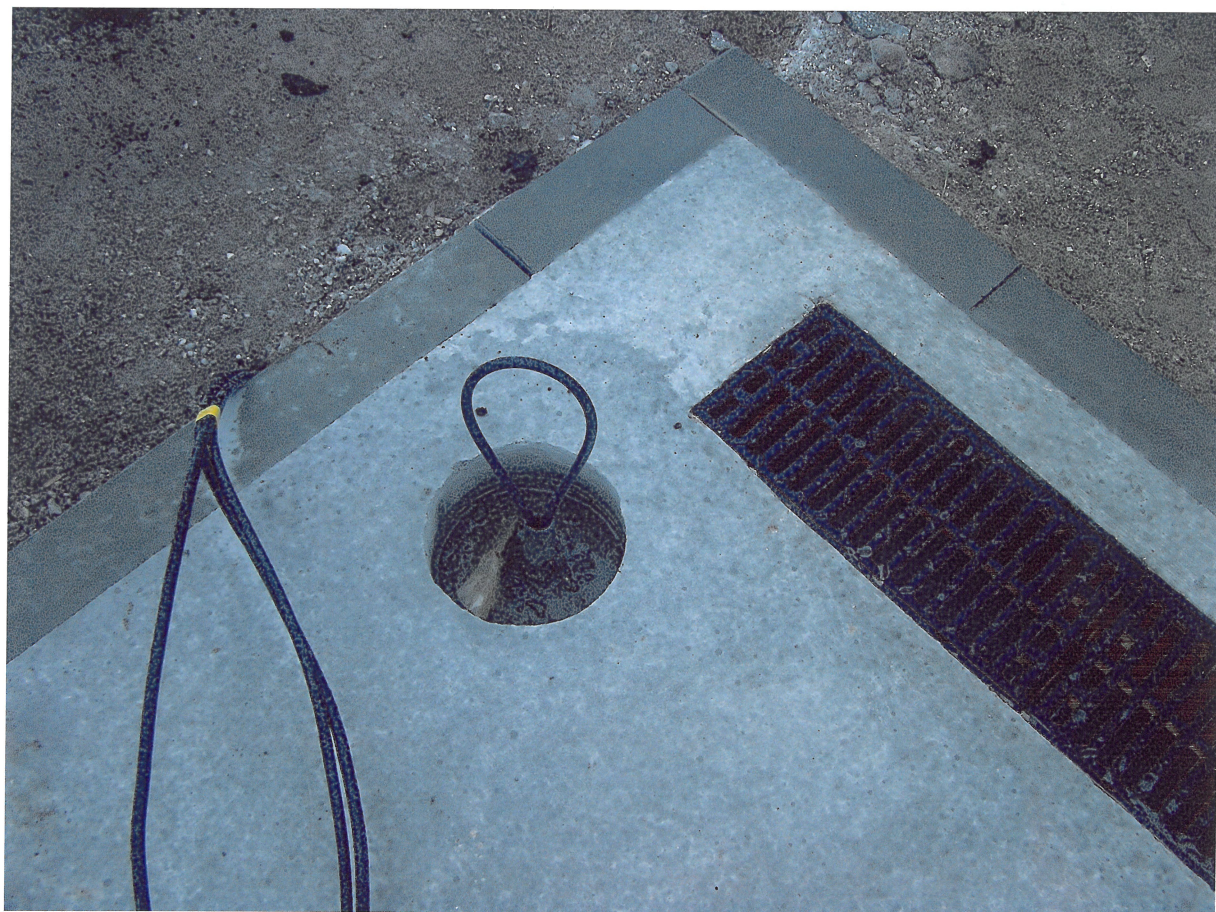
Foto archiwalne nr 2. Instalacje elektryczne – narożnik III
